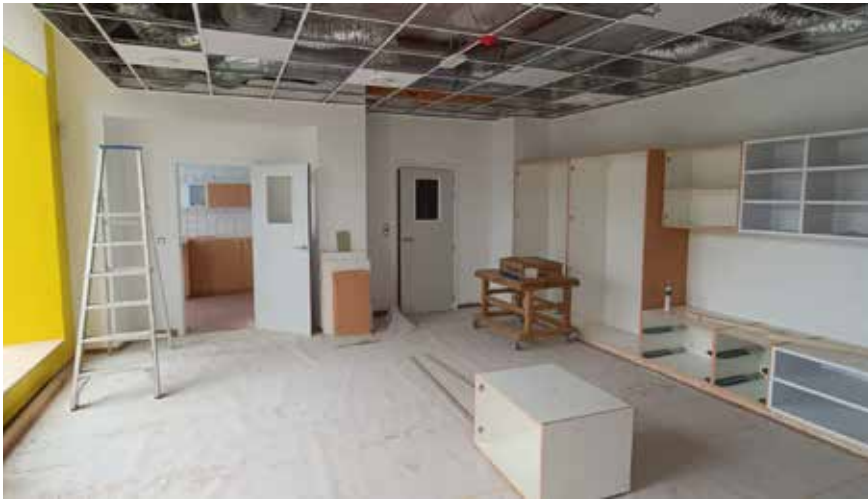
Peintures, couche de finition de l'école de Rivière en travaux : Esteban D, Jeremy T et Michel X.
