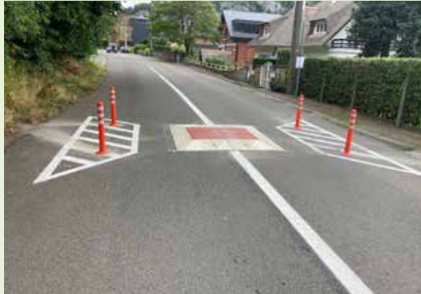
Aménagement sécurité à Profondeville
