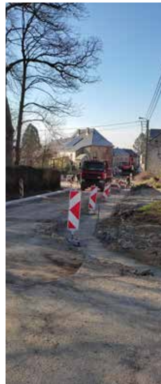
Chantier de réfection rue Joseph Misson à Lesve
