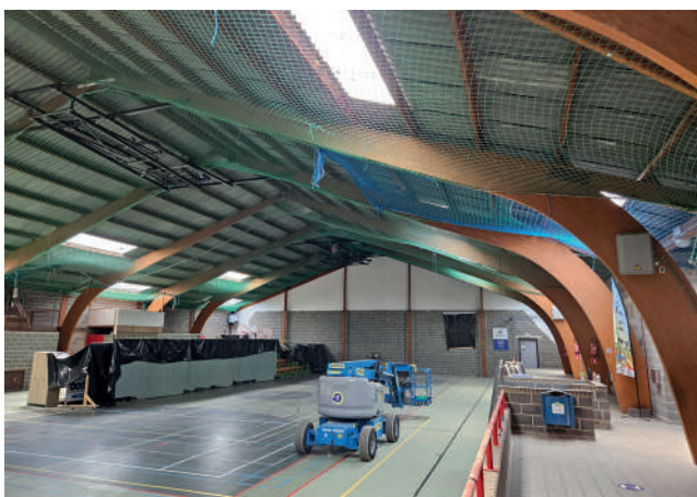
Travaux de rénovation énergétique au Complexe sportif de la Hulle.
