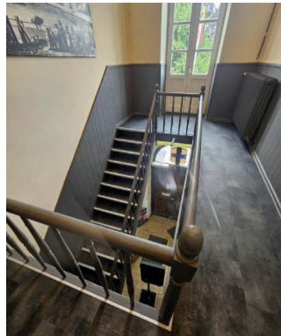
Réfection du sol et mise en peinture du premier étage de la Maison communale. Esteban D., Jérémy T., Didier N.
