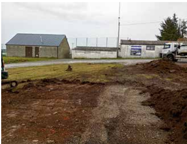
Aménagement du parking du Football de Bois-de-Villers. Vincent T., Renaud T.
