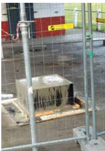
Plot béton au Football de Pro-fondeville. Guillaume W., Vincent T., Anthony L.
