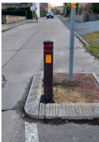
Remplacement de la signalisation après dommage. Anthony L., Guillaume W.
