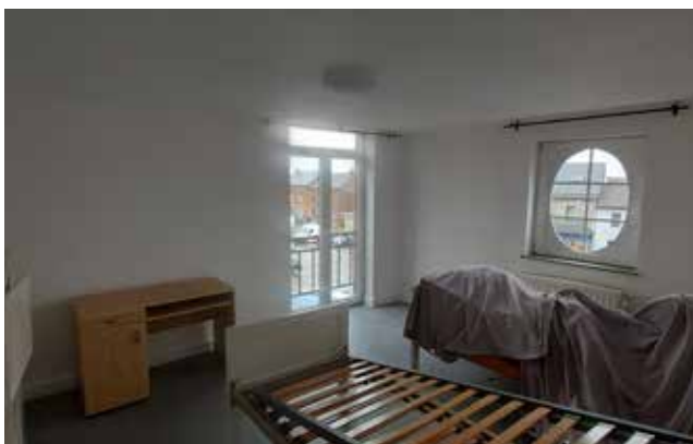
Remise en peinture du logement ILA à Bois-de-Villers - Jeremy T., Esteban D., Frédéric M.
